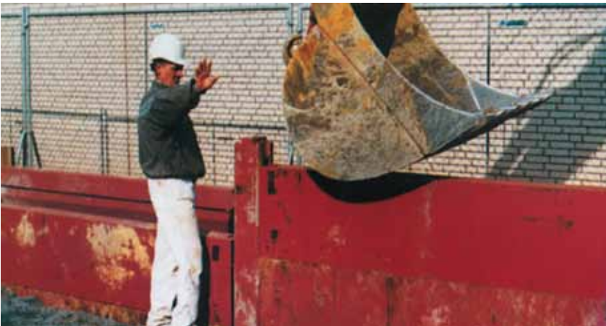
El panel superior reforzado, soporta la presión de la cuchara de la retroexcavadora.
