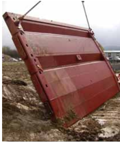
Cada lado del conjunto del módulo de entibación se monta separadamente y se baja poco a poco hasta alcanzar la profundidad de excavación de la zanja.
